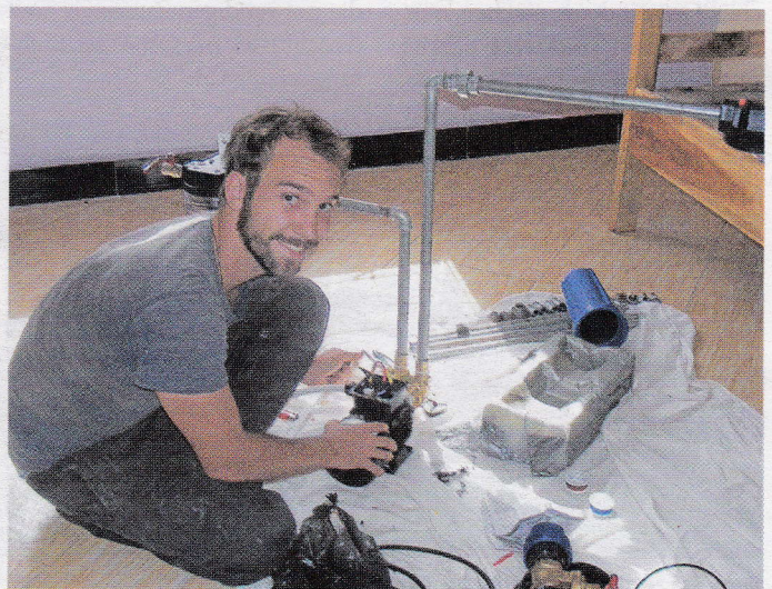
Felix Dörr beim Zusammensetzen der nötigen Teile für die Pumpen
