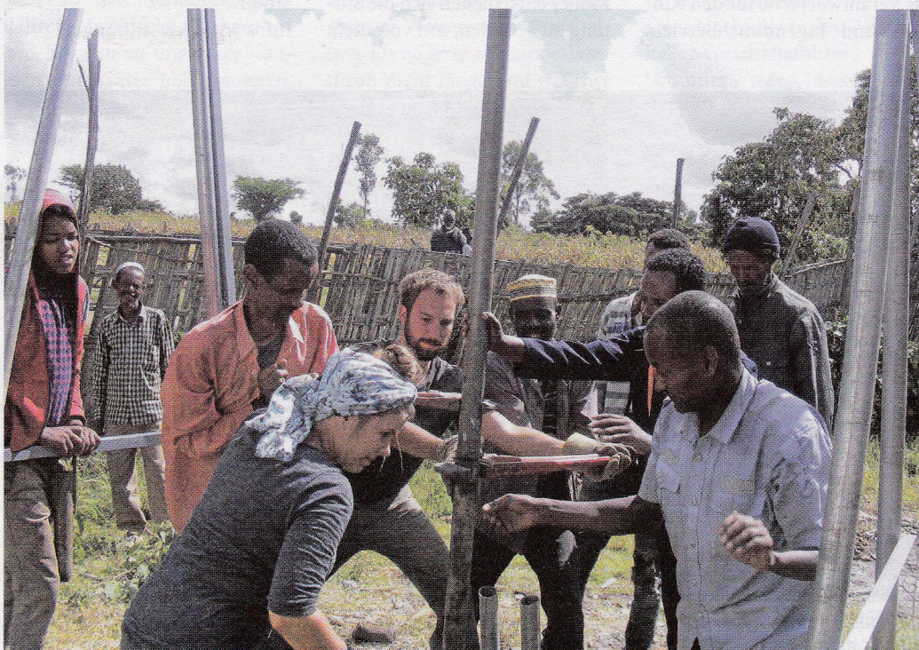
Kathi und Felix bohren mit Hilfe der Bewohner einen neuen Brunnenschacht.
